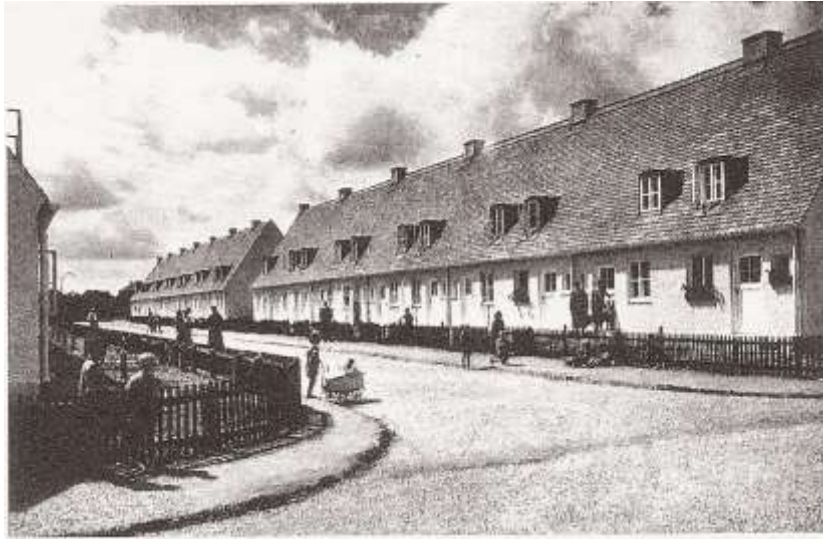
(Volkswohnungsanlage Berg am Laim in München)
